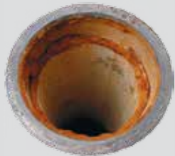
Rohr, ein Jahr nach Einsatz des Hydrocleaners
