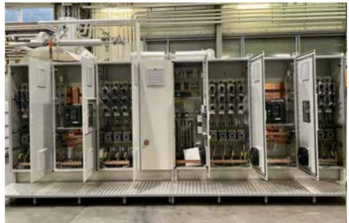
**Auftrag:** ECOTHERM lieferte 2 Elektro-Dampfkessel mit 1344kW elektrischer Leistung, jeweils auf Skids montiert mit Speisewasserbehälter (4000L), Abschlammkühler, Dampfverteiler, Schaltschrank (8m Länge), Umkehrosmose mit 3x 4000L Lagertanks, komplette Verrohrung, Verkabelung und Isolierung. Die Dampfanlage wurde in Übereinstimmung mit allen geltenden europäischen Vorschriften gebaut und vom TÜV abgenommen.
