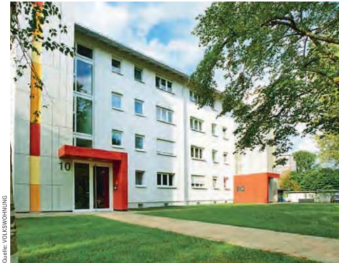
Gebäudekomplex im Hirtenweg 10 (BIOCAT KS 7000 S)
