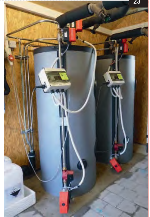
Zwei parallel geschaltete Biocat KS 5D-Geräte sorgen für den nötigen Kalkschutz der Anlagen in der Stiftung Liebenau.
