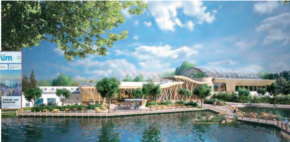
Die innovative Kalkschutz-Lösung überzeugte unter anderem die Betreiber des Center Parcs im Allgäu.
