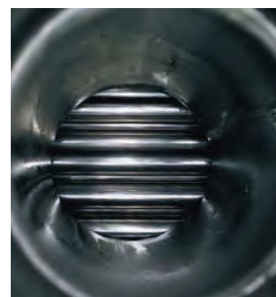
Blick auf den neu eingesetzten Rohrbündelwärmeeüberträger, der durch das BIOCAT Kalkschutzgerät diesen Zustand beibehalten soll
