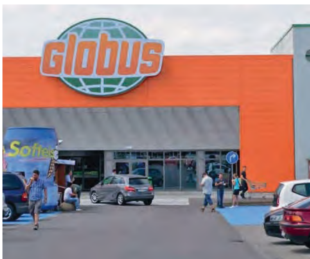
Globus-Markt in Leipzig-Seehausen. Hier wurde ein Kalkschutzgerät von Watercryst installiert. Es arbeitet ohne chemische Zusätze.
