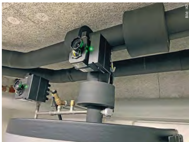
Um die Löschwasserversorgung im Brandfall zu gewährleisten, wurde eine Sonderanfertigung mit einem DN-100-Bypass realisiert.
