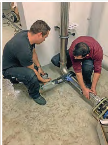
Die Sonderanlage wurde vor Ort vormontiert, der Umschluss erfolgte in nur wenigen Stunden.
