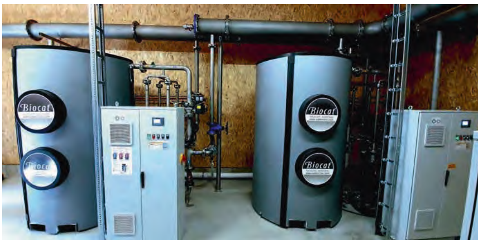
2 x Biocat KS 25D mit Kalkschutzwirkung auf Basis der Biomineralisierung
