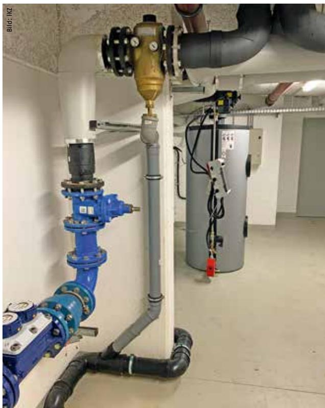
Die „Biacat KS 5 D“ wurde am Hauptwassereingang nach Feinfilter und Druckminderer installiert.
