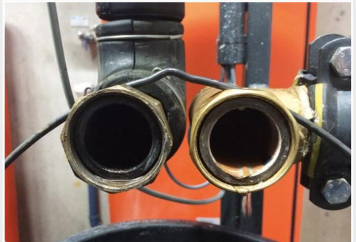
*geöffnete Verrohrung der KESAP-Station nach 12 Monaten (mit BIOCAT)*
